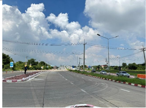
2) สภาพทางหลวงชนบทหมายเลข อย.2053 (สะพานข้ามแม่น้ำเจ้าพระยา)
