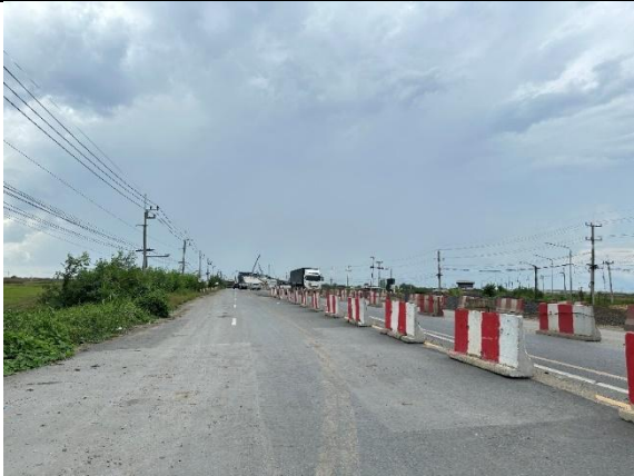
23) สภาพพื้นที่บริเวณทางหลวงหมายเลข 3263 (ก่อสร้างสะพานข้ามโครงการเจ้าพระยา 2)
