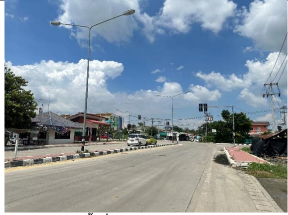
14) สภาพพื้นที่บริเวณจุดตัดทางแยก ทล.3469 (ทางเข้า อบต.ปากกราน)
