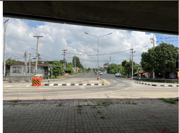
4) สภาพทางหลวงแผ่นดินหมายเลข 3477 (ทางตอนเหนือของถนน อย.2053)
