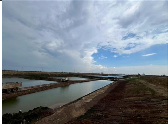
24) สภาพพื้นที่บริเวณก่อสร้างโครงการเจ้าพระยา 2
