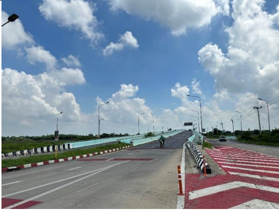
1) สภาพทางหลวงชนบทหมายเลข อย.2053 (สะพานข้ามทางรถไฟสายเหนือ)
