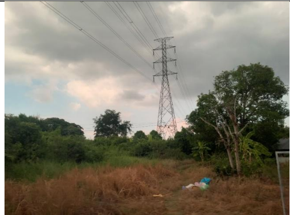
16) แนวสายส่งแรงสูงที่พาดผ่านพื้นที่โครงการ
