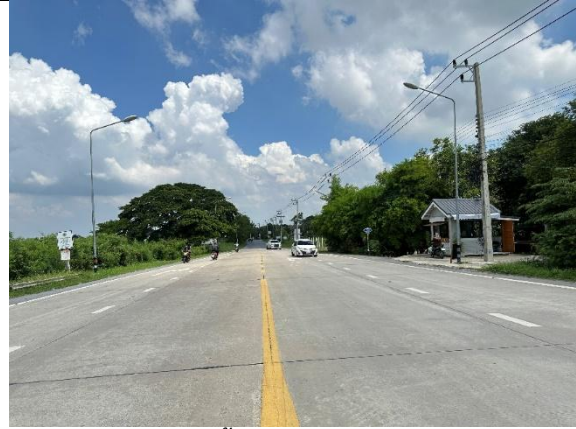
8) สภาพพื้นที่ถนนชุมชนบ้านท้ายคู (บริเวณจุดเริ่มต้นโครงการ ด้านขวาทาง)
